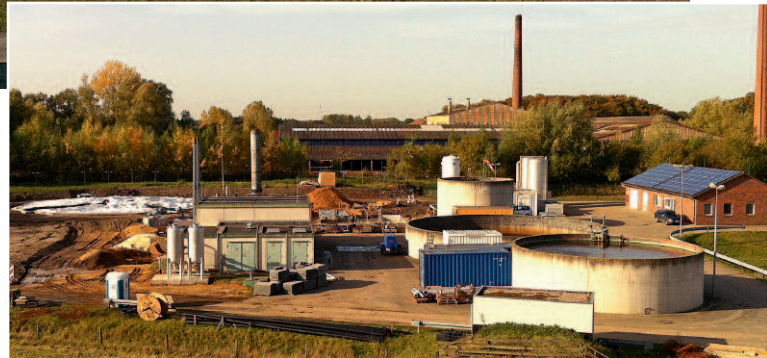
Gasspeicher und Druckwasserwäsche zur Aufbereitung des Biogases zu Biomethan. Die Anlage wurde an die bestehenden Deponie-gas-Bhkw sowie die Sickerwasseraufbereitung (kleines Bild: im Vordergrund) angegliedert.
