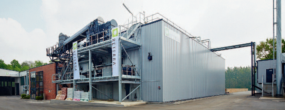
Im Biofilter wird die Abluft aus dem Raum mit dem Fermenteraustrag gereinigt.
