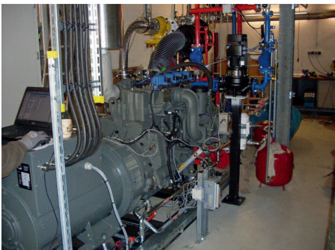
Während die vorhandenen Deponiegas-Bhkw für Biogas ertüchtigt wurden, wurde für die nachlassende Deponiegas-Menge ein neues 160-Kilowatt-Aggregat angeschafft.
